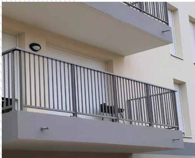
FERIA com gradeamento encostado sob corrimão.
