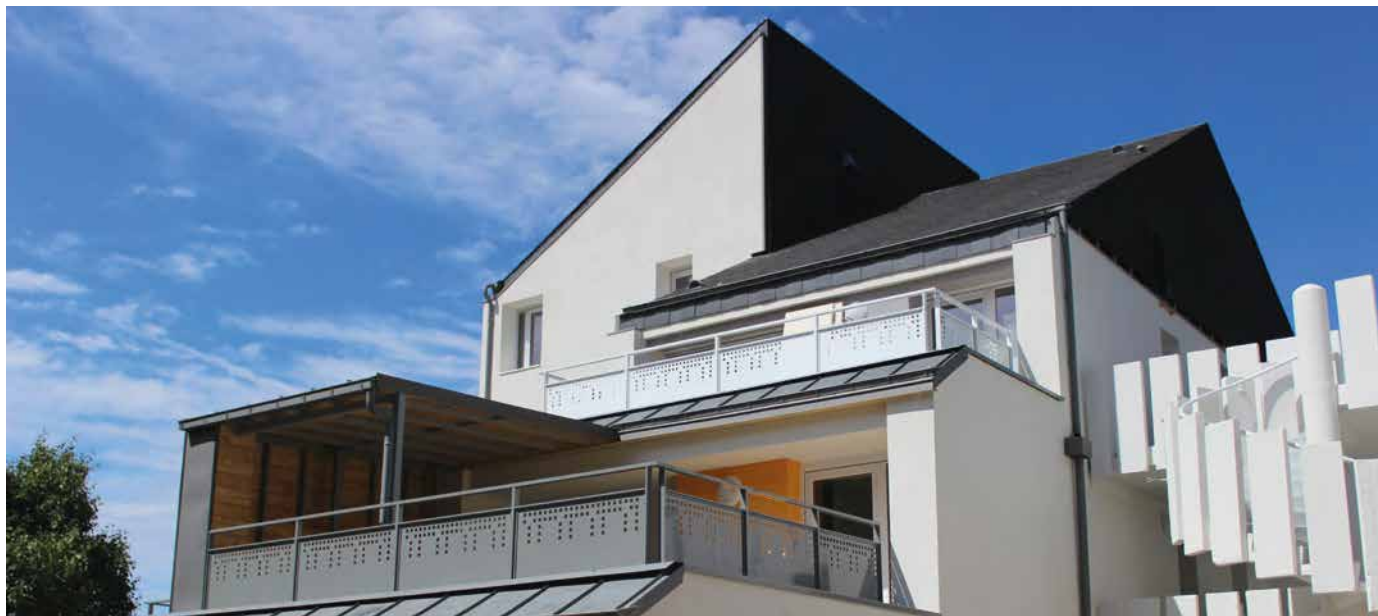
FERIA vazio sob o corrimão com preenchimento em chapa cortada a laser.
