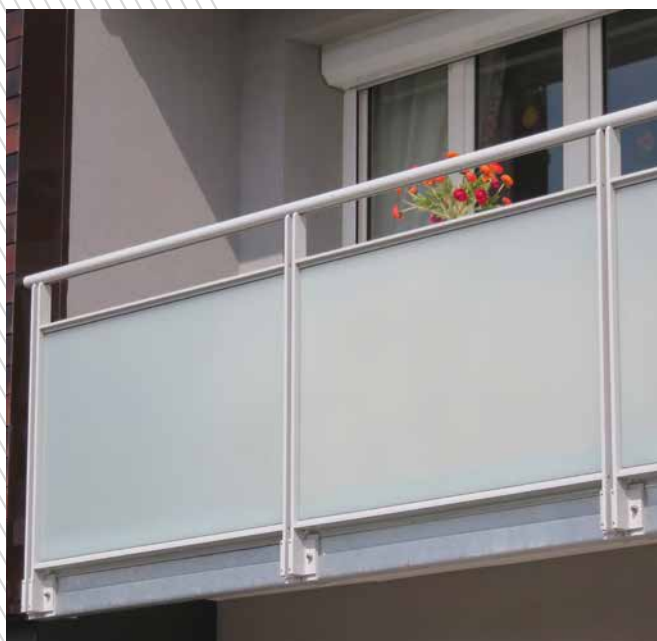
FERIA vazio sob o corrimão, vidro 44/2 opaco e fixação em aplicação
