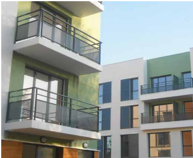
FERIA com travessa intermédia e preenchimento em chapa perfurada.
