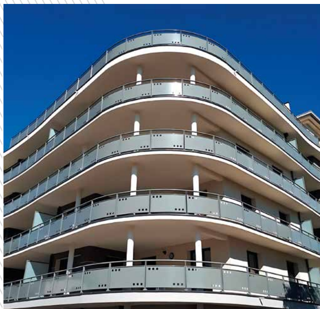
FERIA vazio sob o corrimão com preenchimento em chapa perfurada
