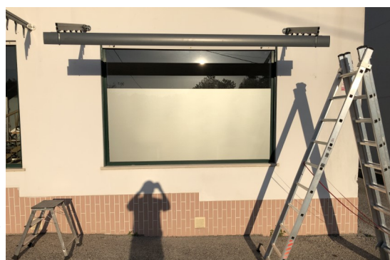
2.2: Montagem 1ª lâmina, verificação e confirmar ângulo
