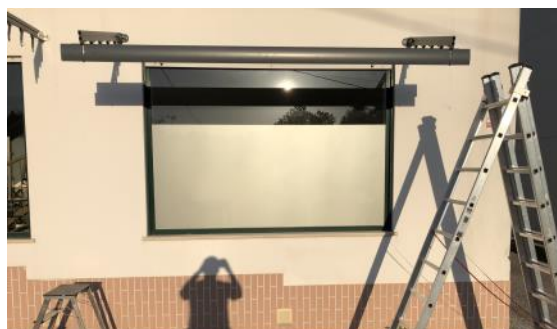
Verification des niveaux - 2.3: Montage des lames suivantes
