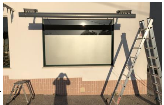
2.2: Montage 1ere lame, verification et confirmer l'angle
